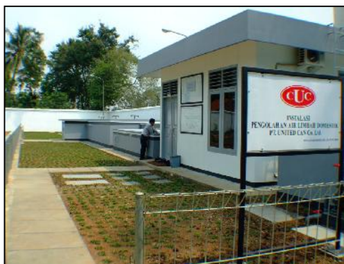
Gambar 2. Foto IPAL Domestik PT. UCC dengan Biofilter Anaerob-aerob
